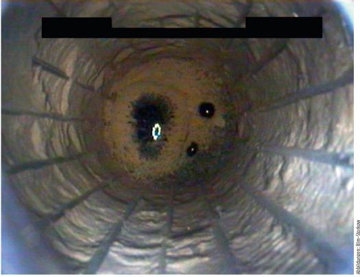
Abb. 1 – Vollständig verockerter Sanierungsbrunnen mit Schwerölphase im Brunnensumpf.
