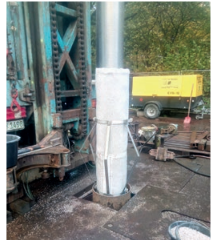
Abb. 5 – Wickeldrahtfilter DN 250 V4A mit Gewebekörben DN 400 für Innenschüttung mit Federführung
